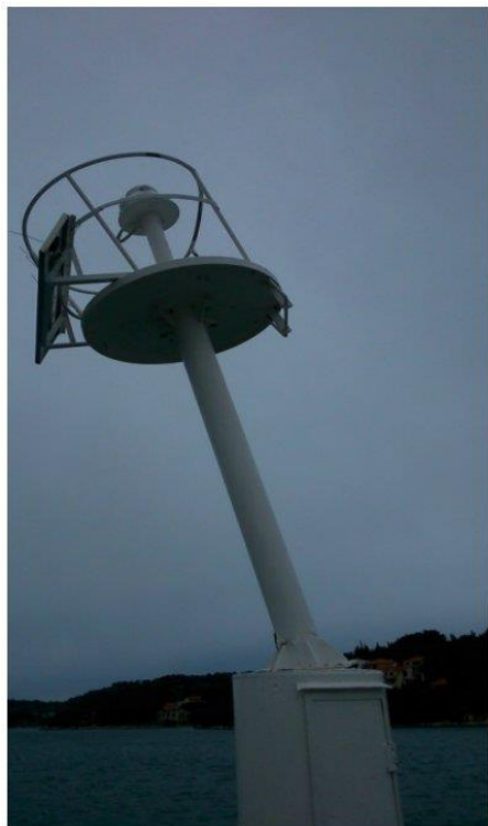
Slika 2. Oštećeno lučko signalno svjetlo
